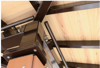
側面膜取付用のパイプフレーム
