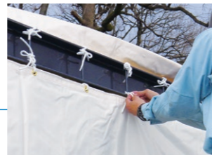
桁外周の丸鋼に付属のテントを固定します。
